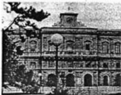
Il municipio di Copparo ieri si è svolta la riunione per fare il punto sullo stato dei lavori
