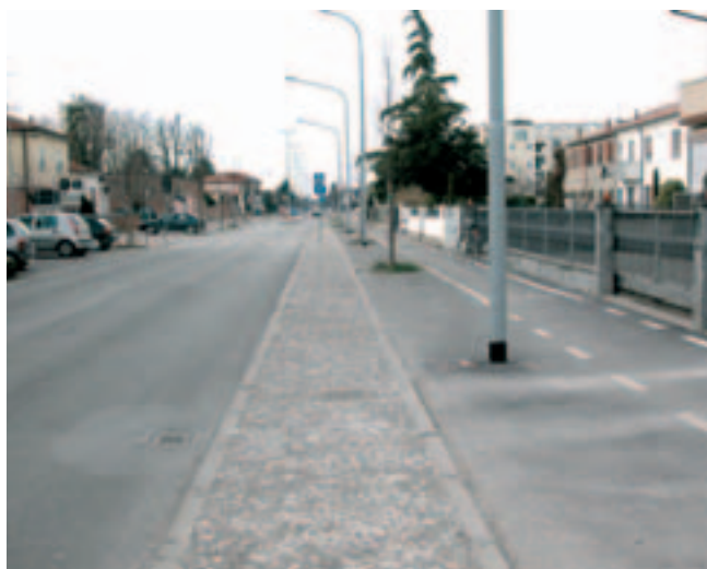
Ristrutturazione viale Idris Ricci.
